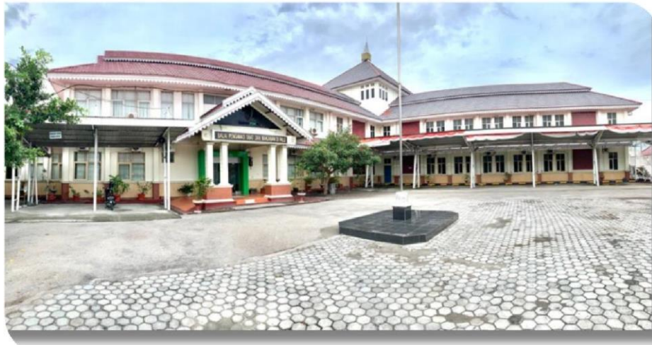
Gambar 2. 2 Bangunan Kantor Balai POM di Palu
